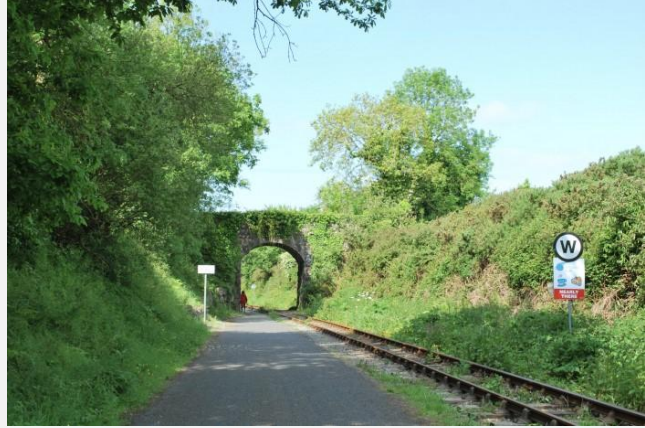
Creidiúintí: J. Sijats, S. Lawrence
